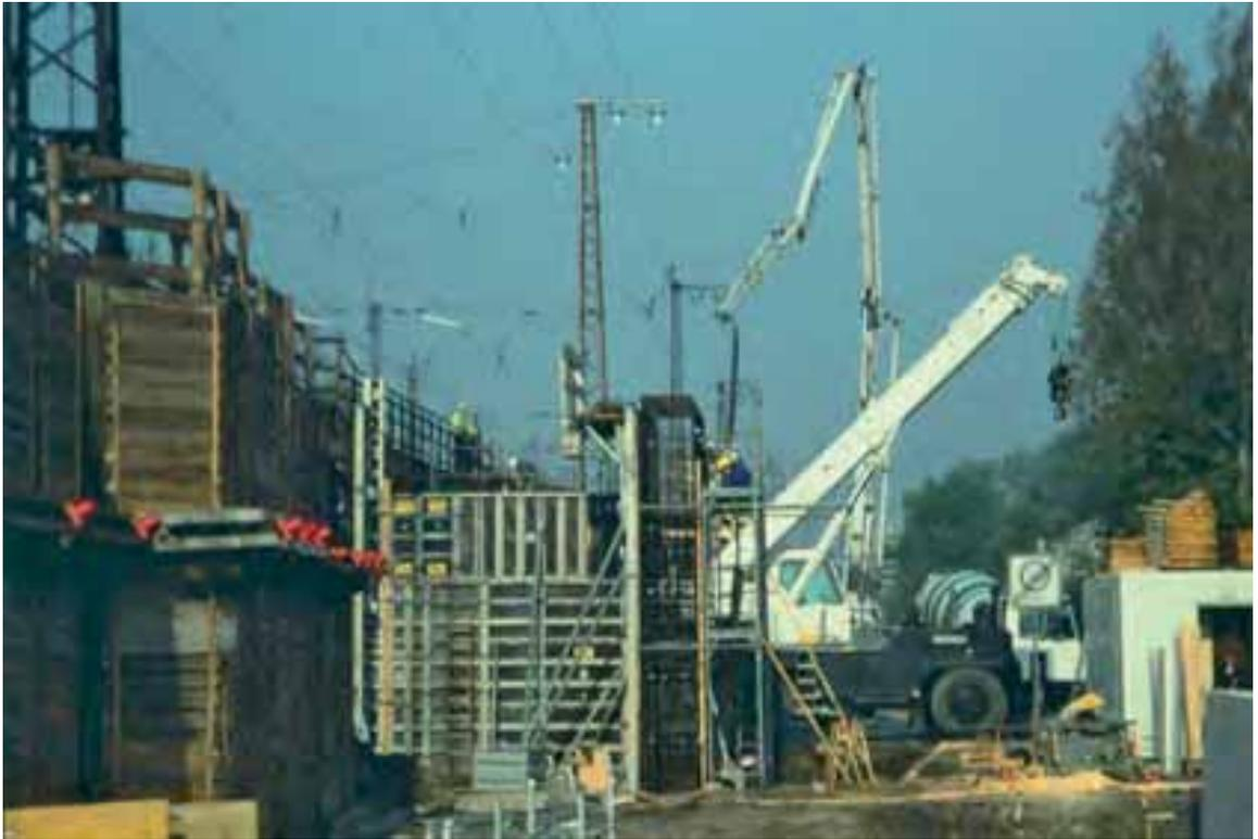
**Abb. 1-2:** Bei Mobilkran und Betonpumpe besteht hier die Gefahr der Annäherung an die auf den Fahrleitungsmasten geführte Speiseleitung.
