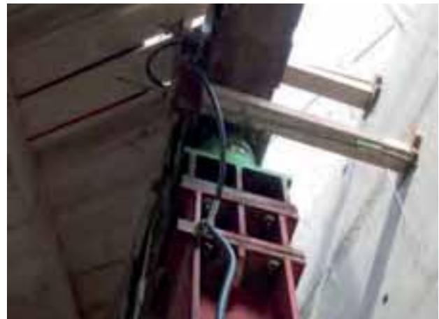
**Abb. 12-18:** Verbindung zur Bahnerdung am Jochträger und an den Stützen des Traggerüsts.
