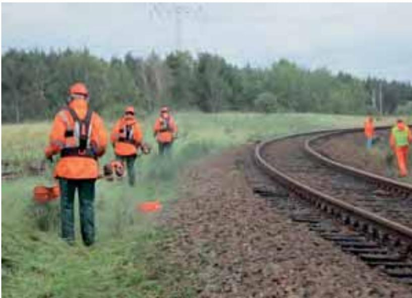
**Abb. 12-23:** Bei der Vegetationspflege mit schneller Durcharbeitung außerhalb des Gleisbereichs kann der Einsatz automatischer Warnsysteme mit individuellen Warngeräten sicherheitstechnisch gerechtfertigt sein.
