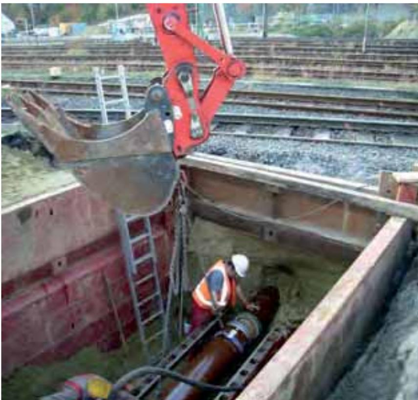
**Abb. 12-7:** Rohrvortrieb unter einer Gleisanlage: Eine Feste Abspernung wäre erforderlich, um das unbeabsichtigte Hineingeraten in den Gleisbereich zu verhindern und die Grenze des Arbeitsbereichs zu kennzeichnen. Der Stirnverbau muss ergänzt werden.
