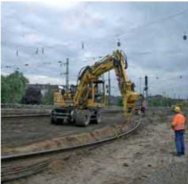
**Abb. 7-1:** Anschläger im Sichtbereich des Maschinenführers. Warnkleidung ist geschlossen zu tragen.
