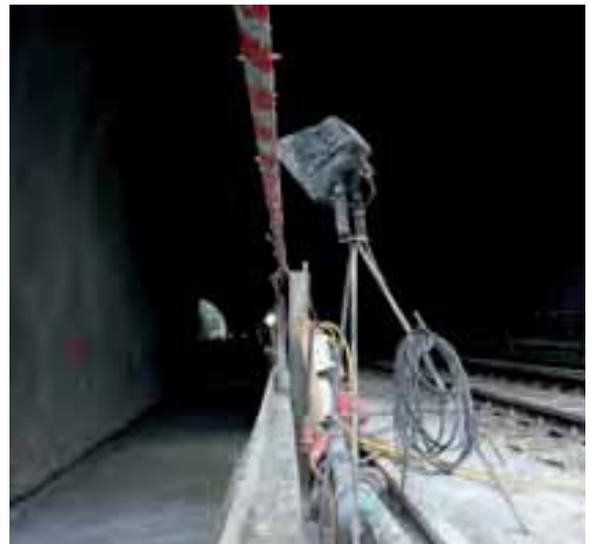
**Abb. 12-3:** Der Bereich hinter der Festen Absperrung darf nicht zur Materiallagerung benutzt werden. Wenn der Zugriff z. B. auf Baustellen-Versorgungsleitungen notwendig ist, ist auch für kurzzeitige Tätigkeiten eine Sicherung erforderlich.
