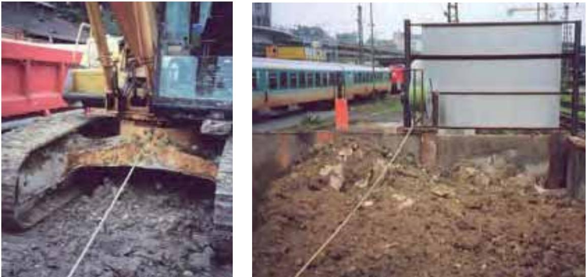
Abb. 4-6: Bagger mit Kabeltrommel zum Aufwickeln der Schlepperde.
