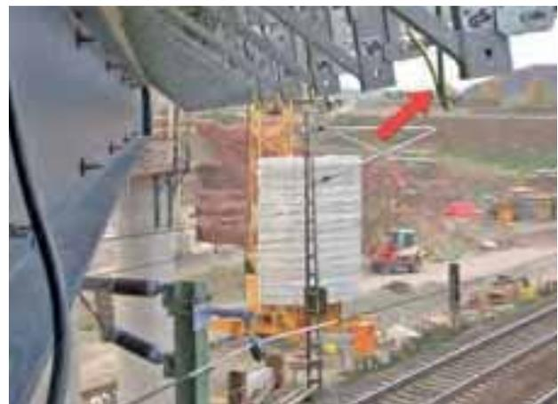
**Abb. 12-19:** Verbindung zur Bahnerdung am Traggerüst an den Trägern der Kappenschalung.
