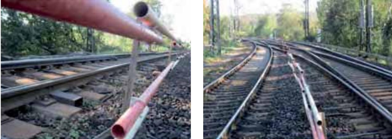
**Abb. 2-8:** Geeignete Feste Absperrungen können auch im Bereich von Weichenzungen montiert werden (links). Unterbrechungen der Feste Absperrungen in Weichenbereichen werden mit sichtbarer Abgrenzung kenntlich gemacht und während der Arbeiten z. B. mit Absperrosten gesichert (rechts).
