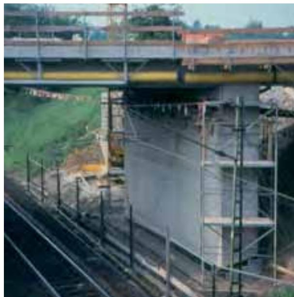
**Abb. 1-1:** Beispiel zum Gleisbereich: Beim Hantieren mit Gerüstrohren neben dem Gleis besteht die Gefahr, in den durch Druck- und Sogeinwirkungen gefährdeten Bereich hineinzugeraten oder den Schutzabstand zu unter Spannung stehenden Teilen der Fahrleitungsanlage zu unterschreiten. Der Gleisbereich umfasst in diesem Fall auch die Arbeitsplätze der Gerüstbauer. Bei der DB schließt der Gleisbereich den Gefahrenbereich ein (vgl. Anhang 3).
