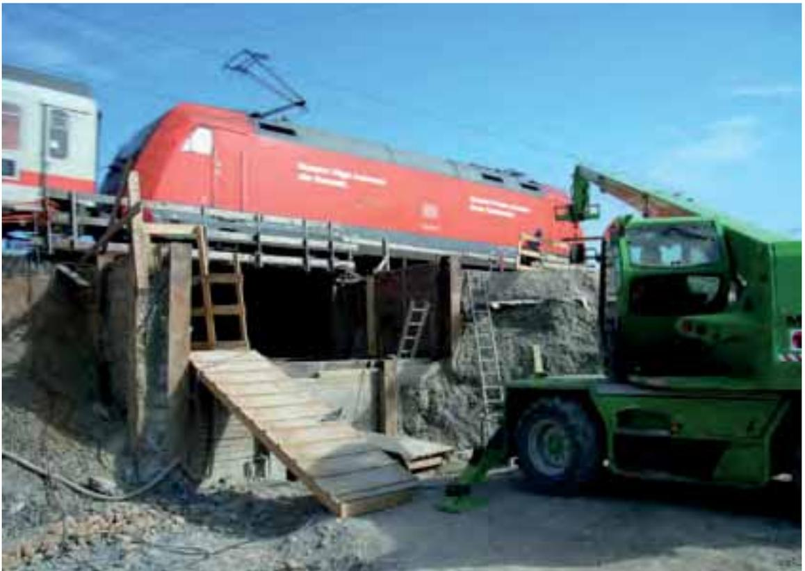
**Abb. 12-12:** Für den kurzzeitig in der Nähe des Gleisbereichs eingesetzten Teleskopstapler besteht die Gefahr einer unbeabsichtigten Annäherung an die Fahrleitung. Es wird eine Bahnerdung eingesetzt.
