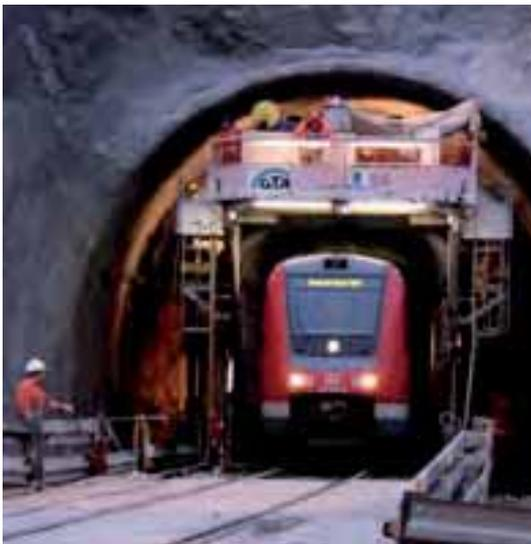
**Abb. 12-2:** Behelfsübergang für Arbeitskräfte und Maschinen, der nach Gleissperrung benutzt wird.
