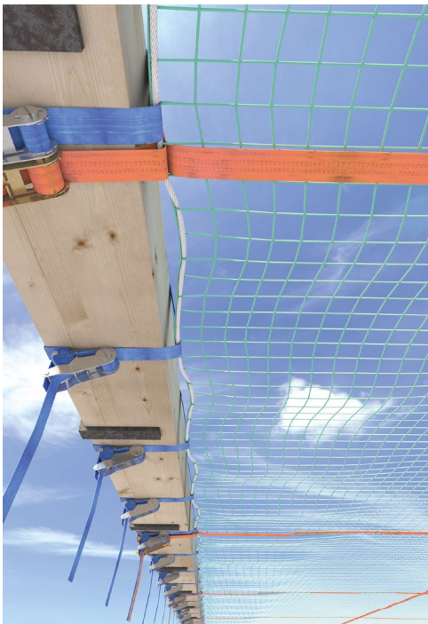
Abb. 5 Randbefestigung mit Anschlaggurten (Quelle: Baustein B 105)
