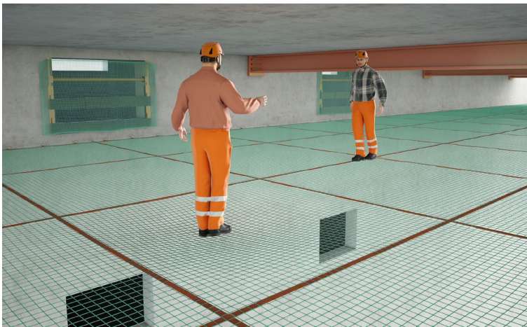
Abb. 1 Montiertes Arbeitsplattformnetz in einer Stahl-/Betonkonstruktion
