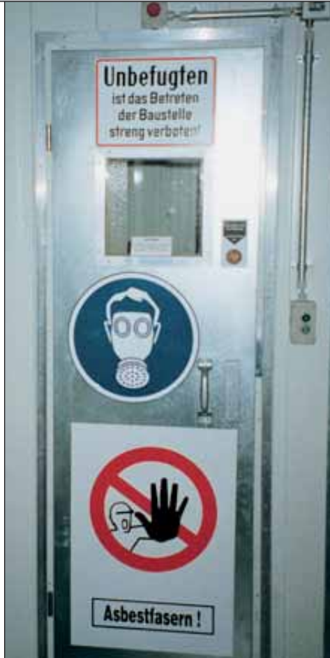
Mehrkammerpersonenschleuse. Die Kammern wurden versetzt angeordnet.
