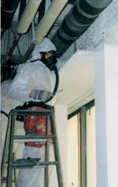
Abnehmen der Zwischendeckenplatten im Randbereich
