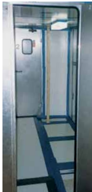
Materialschleuse, Kammer 1 (Weißbereich), offen
