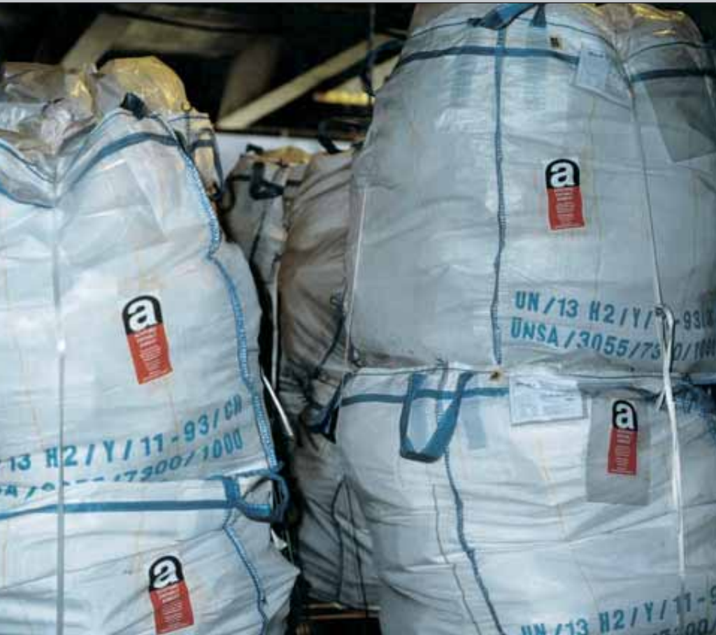
In Big-Bags verpackter Asbestabfall
