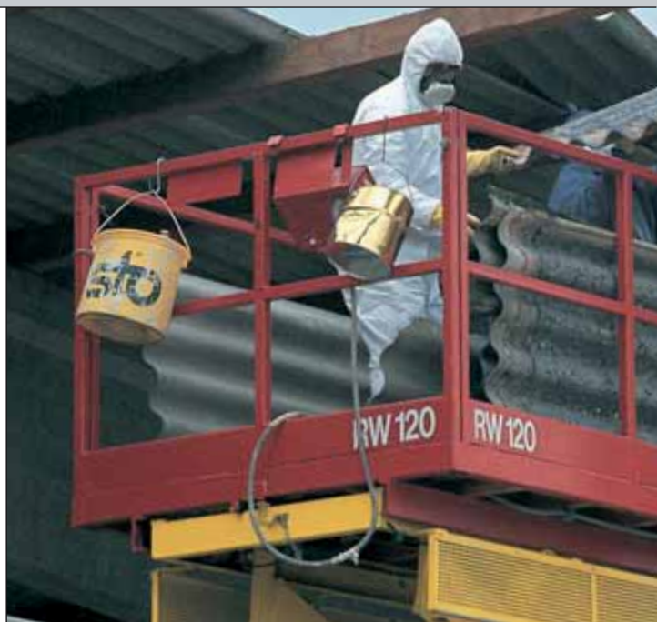
Abnehmen der Dachplatten (von innen) von einer Hubarbeitsbühne aus
