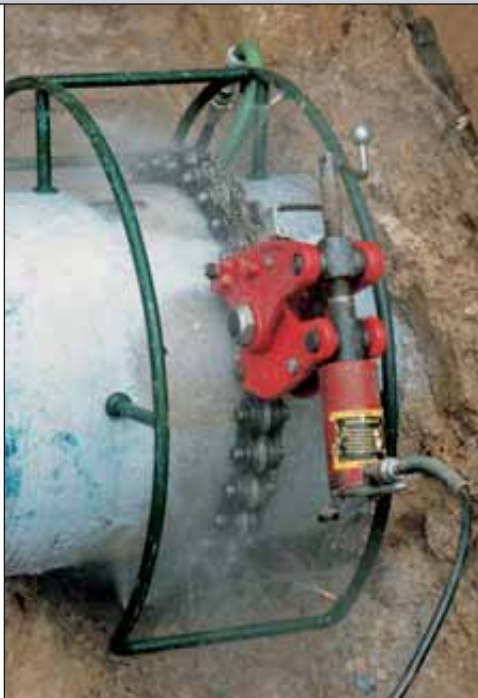
Trennen eines AZ-Rohres mittels Kettenroherschneider (BT 3)
