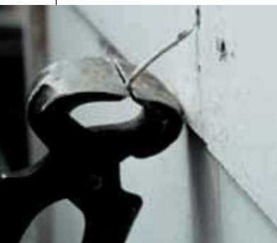
Lösen der Befestigungen mit einer Armierzange
