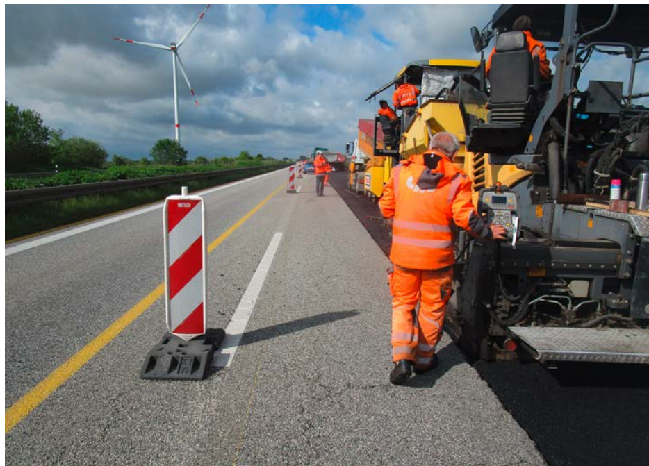
Messen der Mindestbreite des Arbeitsplatzes und des seitlichen Sicherheitsabstands beim Einbau der Deckschicht Foto: Langer, BG BAU
