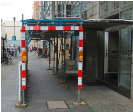
Absperrschranken 10 cm breit am Gerüst direkt montiert
