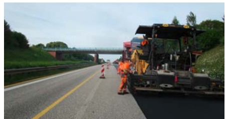
Asphalteinbau Foto: Langer, BG BAU
