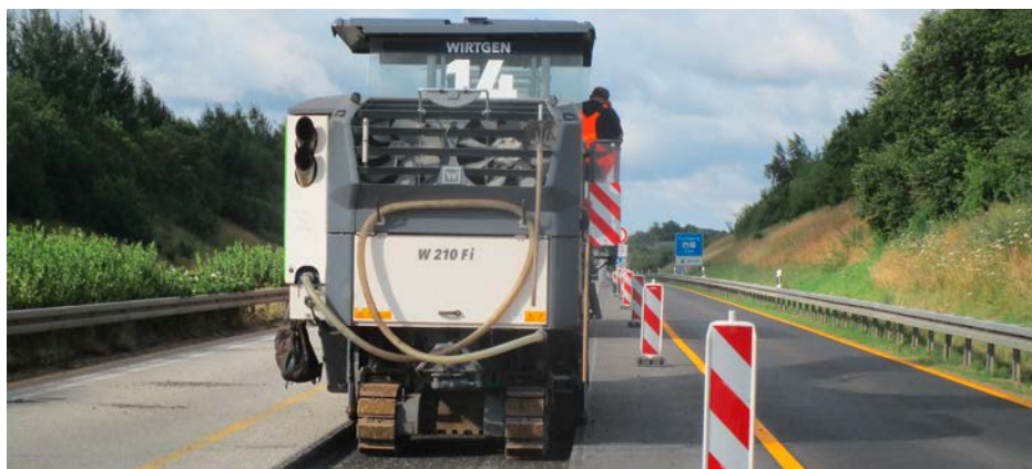
Fräsarbeiten Foto: Langer, BG BAU
