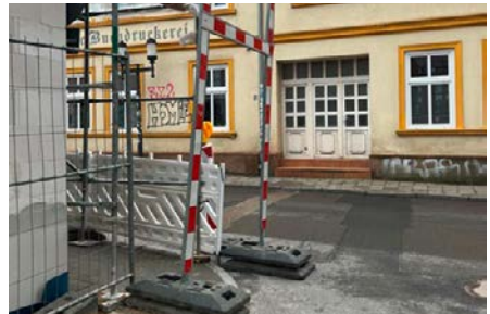
Durchgangsrahmen mit Aufstellvorrichtungen
