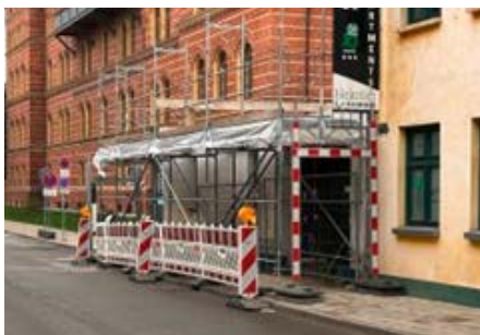
Absperrschranken als Durchgangsrahmen mit Aufstellvorrichtungen vor dem Gerüst aufgestellt Fotos: Langer, BG BAU
