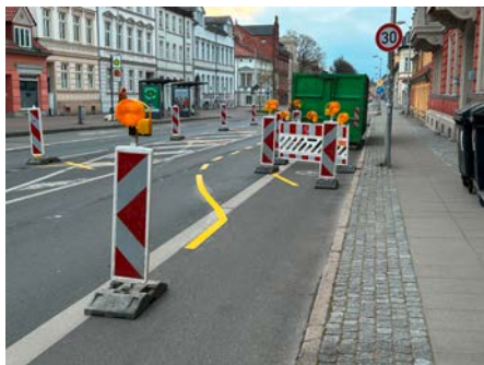
Sicherung eines Wechselbehälters wie eine Arbeitsstelle, wobei hier auch zu beachten ist, dass die Leitbaken hinter der Gelbmarkierung stehen müssen.
