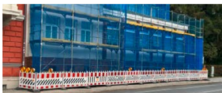
Quer- und Längsabspernung eines Gerüsts
