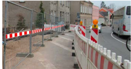
Kennzeichnung Bauzaun im Gehwegbereich mit 100 mm Absperrschranken
