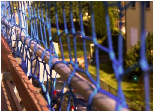
Absturzsicherung - BG BAU
