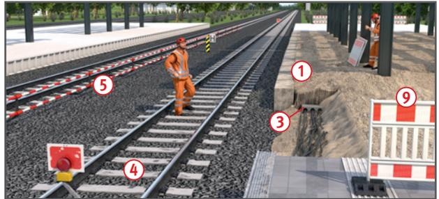
Gleissperrung (z. B. Abbruch der alten Bahnsteigkante, Fundamentbau, Versetzen von Winkelstützen).
