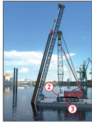
• Muss der Bereich unter der Rammausrüstung aufgrund des Rammverfahrens vorübergehend betreten werden, ist eine mechanische Verriegelung vorzunehmen (Absteck- oder Halteeinrichtung).
