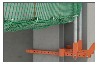
Doppelpostenkonstruktion am Endposten.
