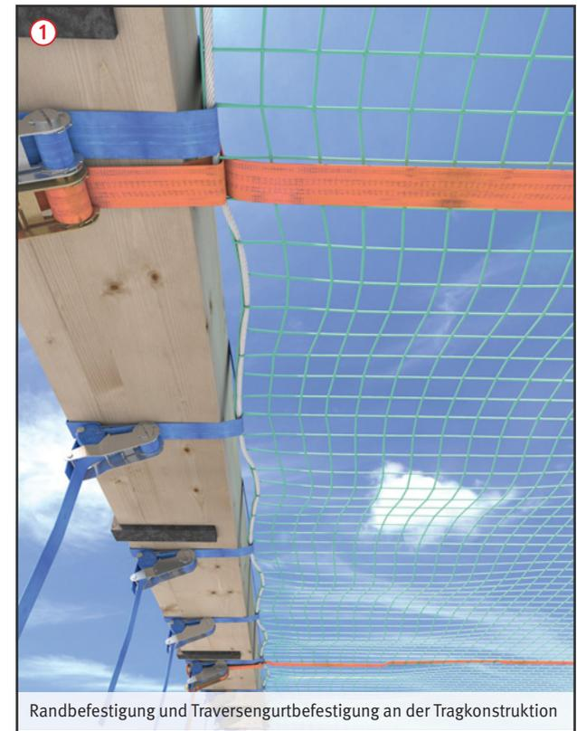
Randbefestigung und Traversengurtbefestigung an der Tragkonstruktion
