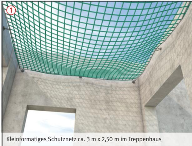
Kleinformatiges Schutznetz ca. 3 m x 2,50 m im Treppenhaus
