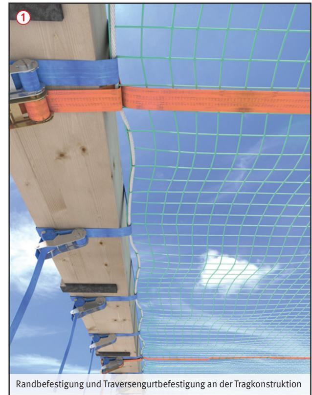
Randbefestigung und Traversengurtbefestigung an der Tragkonstruktion
