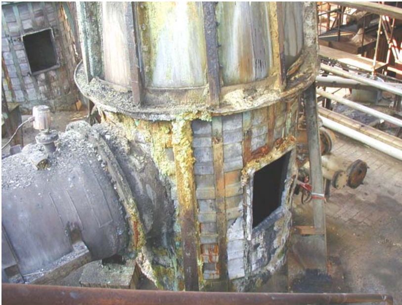
Abbildung 2: In dieses Mannloch steigen die Säureschutzbau-Monteure zu Sanierungsarbeiten ein
