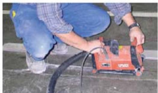
Moderna Schützgarala mit integrierter Absaugtechnik ermöglichen staubarmes Schneiden in Wand und Boden.
