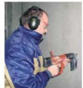
Bei Bohr- und Bolzensetzarbeiten wurden schnell gehörschädigende Lärmpegel erreicht. Daher immer Gehörschutz tragen!
