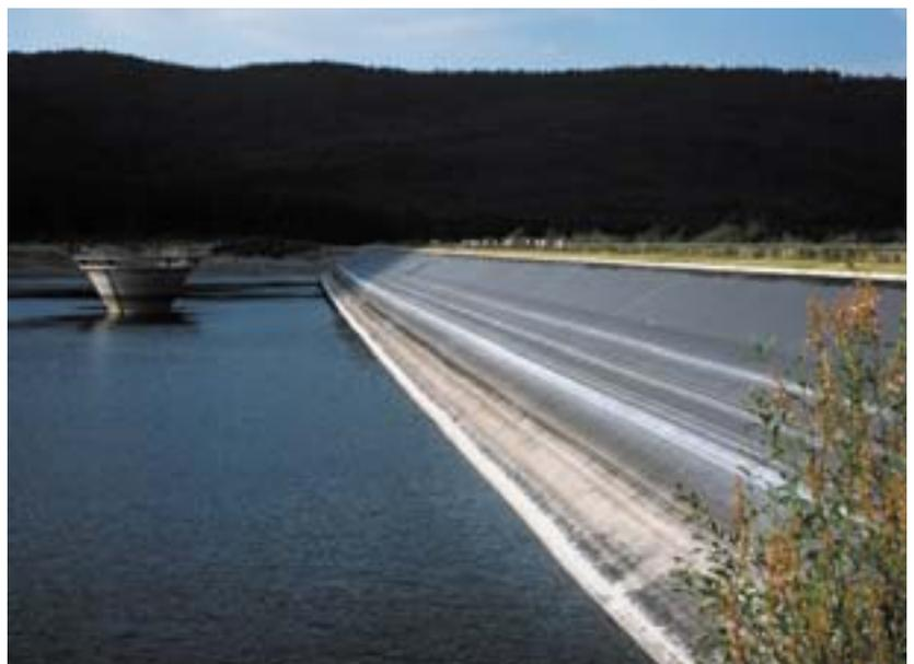
Trinkwassertalsperre – mit Asphalt abgedichtet
