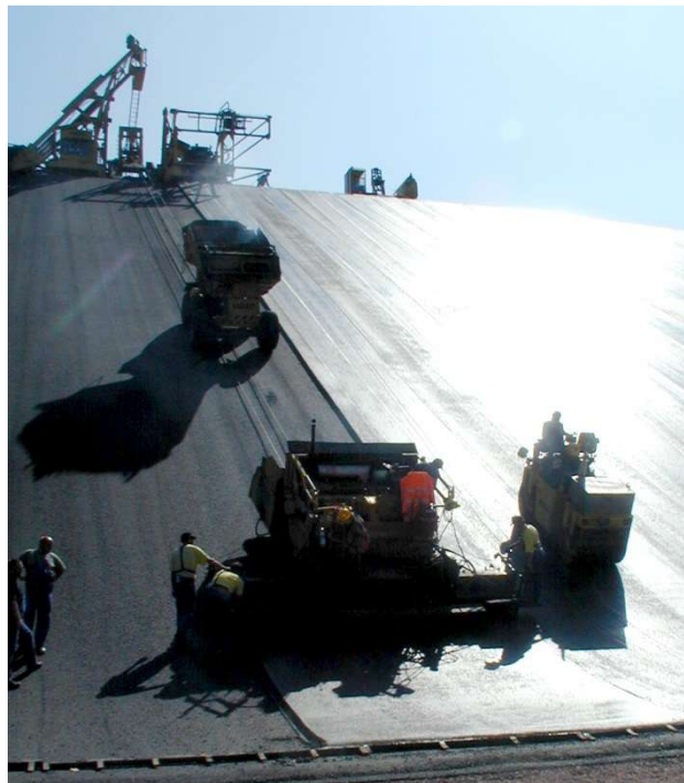
Abbildung A1: Winde (oben), Beschicker (mitte) sowie Fertiger und Walze (unten) beim Asphaltieren eines Wasserrückhaltebeckens
