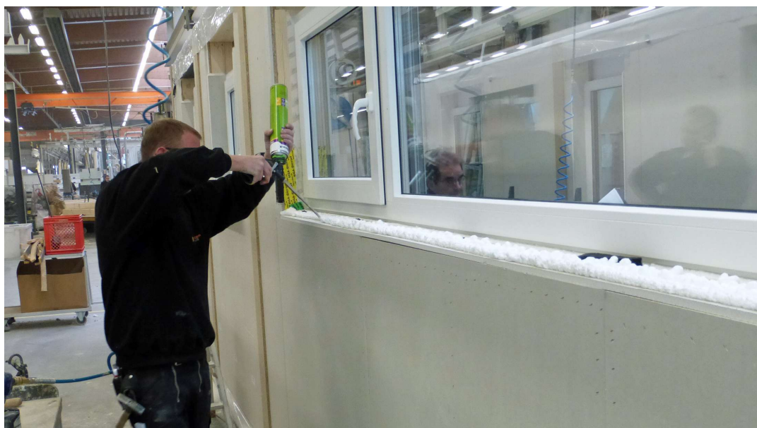
Abbildung 1: Ausschäumen eines Fensters bei der Fertighausherstellung
