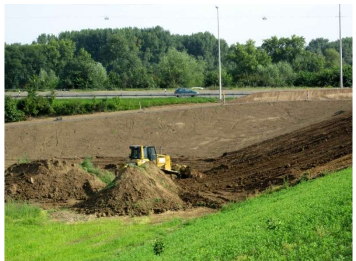
Abbildung 4: Planierraupe in einer Senke (Dieselrußpartikel Konzentration im Fahrerhaus: 0,021 \text{ mg/m}^3 )
