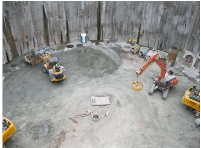
Abbildung 5: Einsatz dieselbetriebener Baumaschinen in einem Schacht mit einer Grundfläche über 100 m 2
