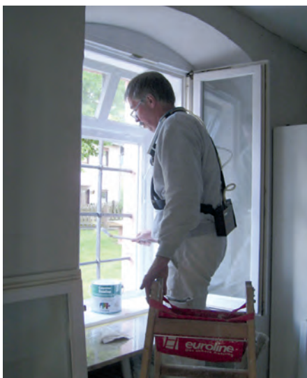
Abb. 3: Personenbezogene Expositionsmessung bei Lackierarbeiten an einem Fenster
