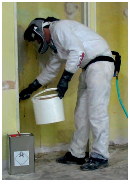
Abb. 2: Wurde in der Praxis noch nie beobachtet – so müsste mit dichlormethanhaltigen Abbeizern gearbeitet werden
