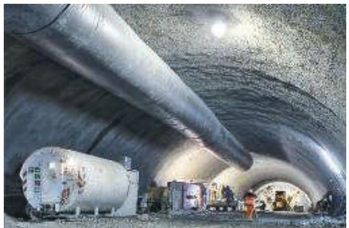
Abb. 7: Belüftung einer Tunnelbaustelle
