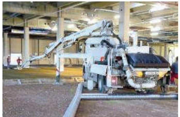
Abb. 4: Betonpumpe in einer Halle mit Absaugung am Auspuff
