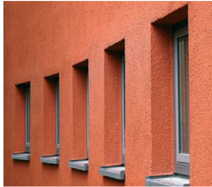
Abb. 1: Fassadenbeschichtung (Foto: Heiner Witthake, www.Fotolia.com)
