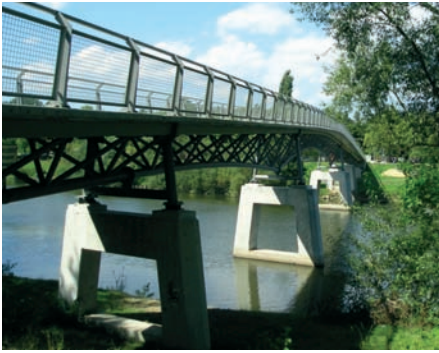
Abb. 6: Gärtnerplatzbrücke in Kassel aus Ultrahochfestem Beton (Foto: Gunreben)
