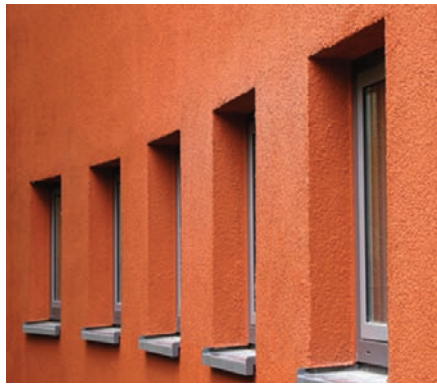
Abb. 1: Fassadenbeschichtung (Foto: Heiner Witthake, www.Fotolia.com)
