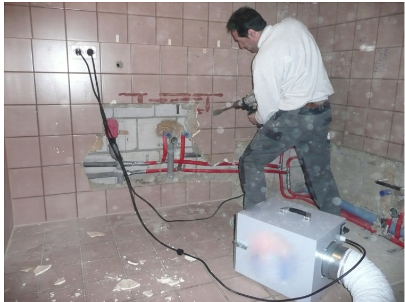
Abbildung 2: Einsatz eines Luftreinigers beim Abstemmen von Fliesen
