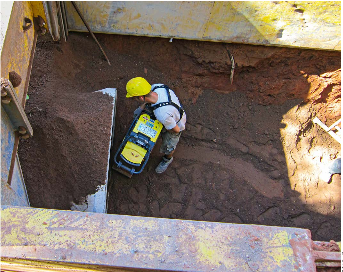
Verdichtungsarbeiten in einem tiefen Graben
