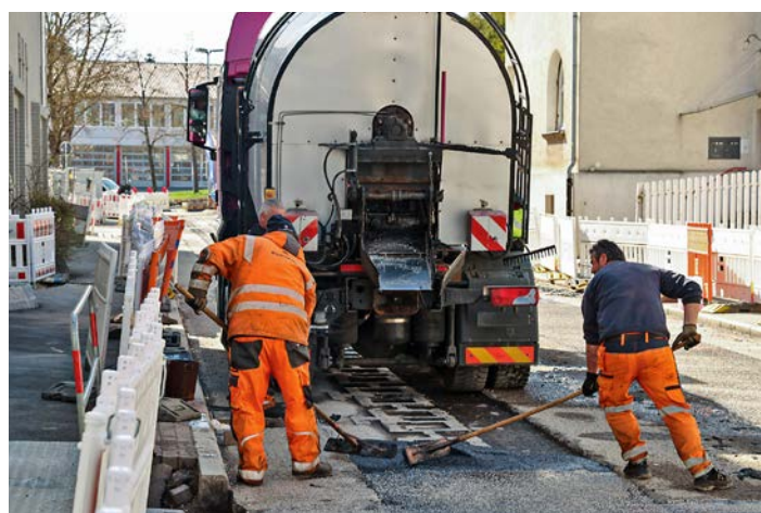
Straßenbauarbeiten zur Sicherstellung des Schichtenverbundes
