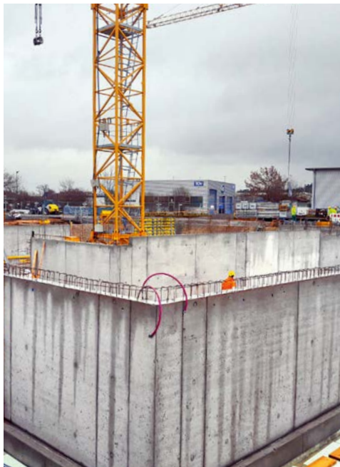
Schararbeiten an den Ort beton-Kellerwänden
