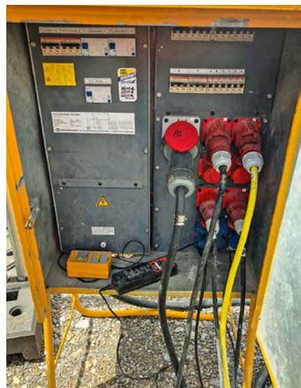
Baustromverteiler mit FI vom Typ B.
