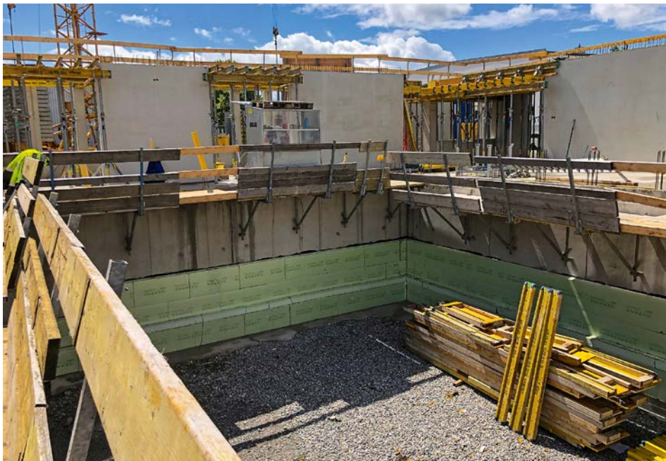
Absturzicherungen rund um den künftigen Lichthof des Polizeigebäudes
