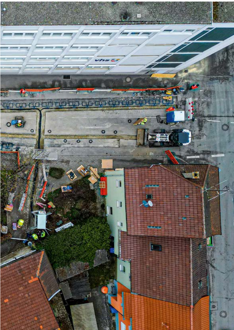
In die Straßen werden Spulen (Coils) eingelegt.
