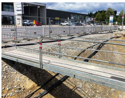
Auf der Baustelle gibt es mehrere kurze und lange Stege, auch Grabenbrücken genannt.
