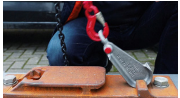
Position des Weichenschwellenhakens beim Hebevorgang
